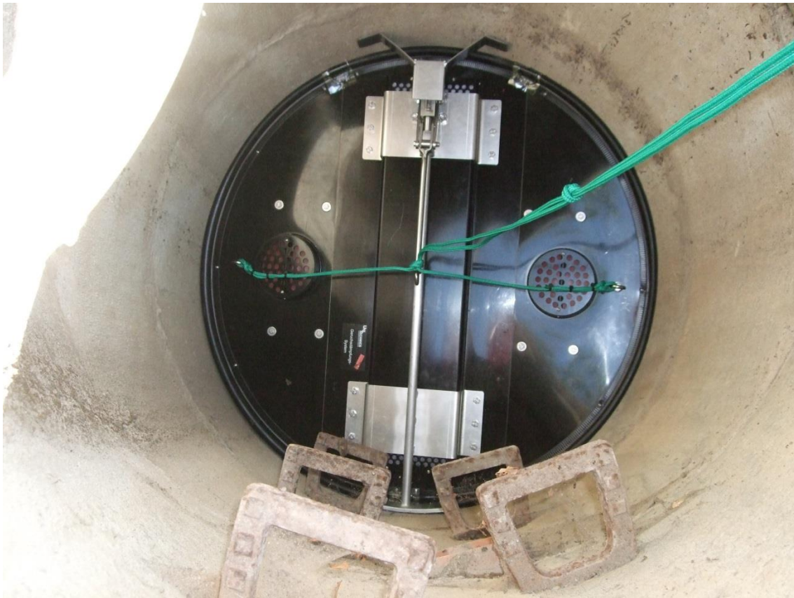
Abbildung 7.11 – Geruchsverschlussystem in Schacht eingesetzt
