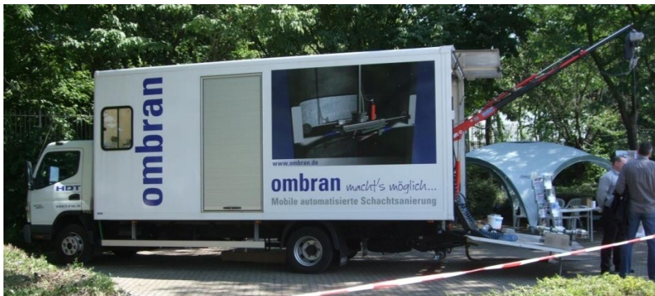
Abbildung 7.6 – 7,5t LKW mit Schachtsanierungsequipment
