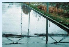
Nicht abfließendes Oberflächenwasser
