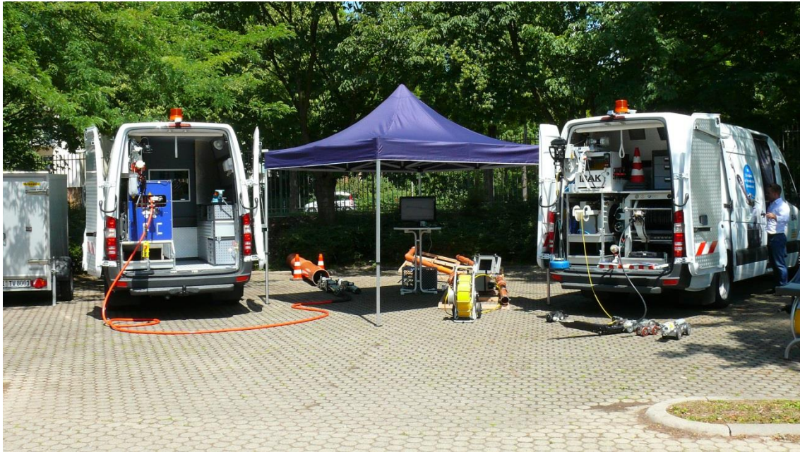
Abbildung 7.2 – Einsatzfahrzeuge mit Fräsroboter (links) und Kamerasystemen (rechts)
