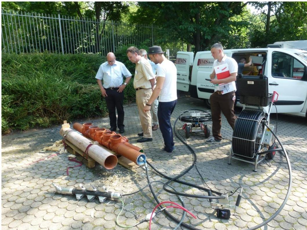
Abbildung 26 - Fräs- und Hochdruck-Spülroboter
