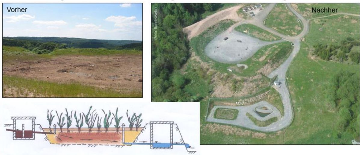
Beispiel Sprengplatz Wildflecken: Sanierung und anschließend Sicherung durch eine Pflanzenkläranlage (Fotos: Bundeswehr)
